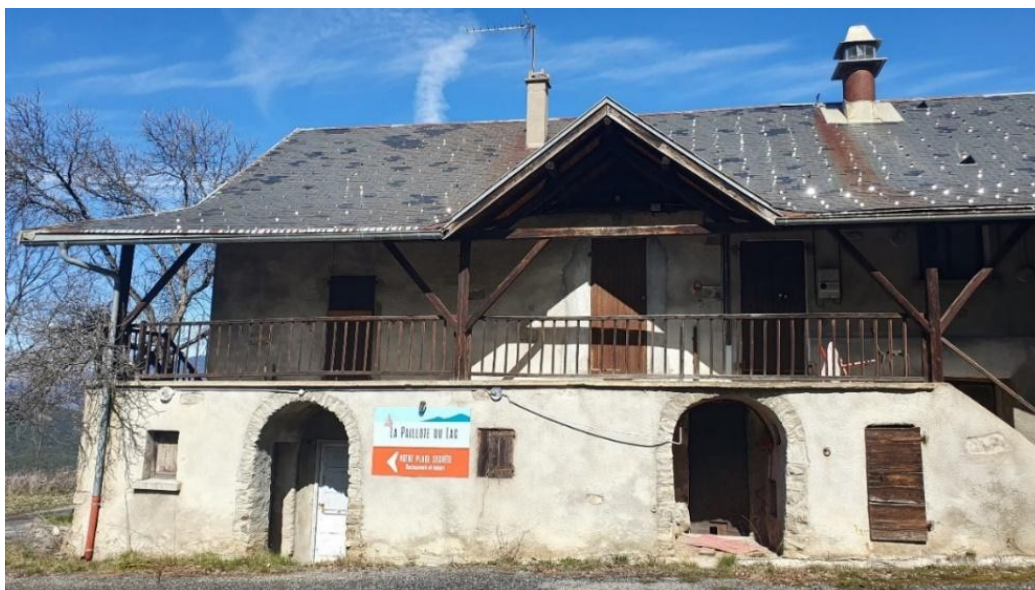
Figure 20 : Photo du bâtiment Le Foreston abritant la colonie de Petits rhinolophes
